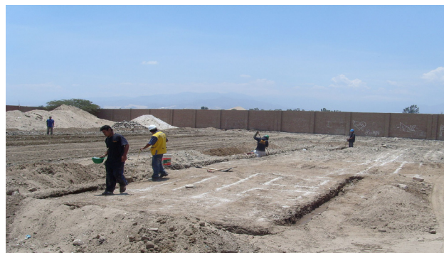
I februari 2010 togs de första spadtagen för byggnationen av SysTech's första bilprovningensanläggning i Ica, Peru, som planeras öppnas under juni månad
