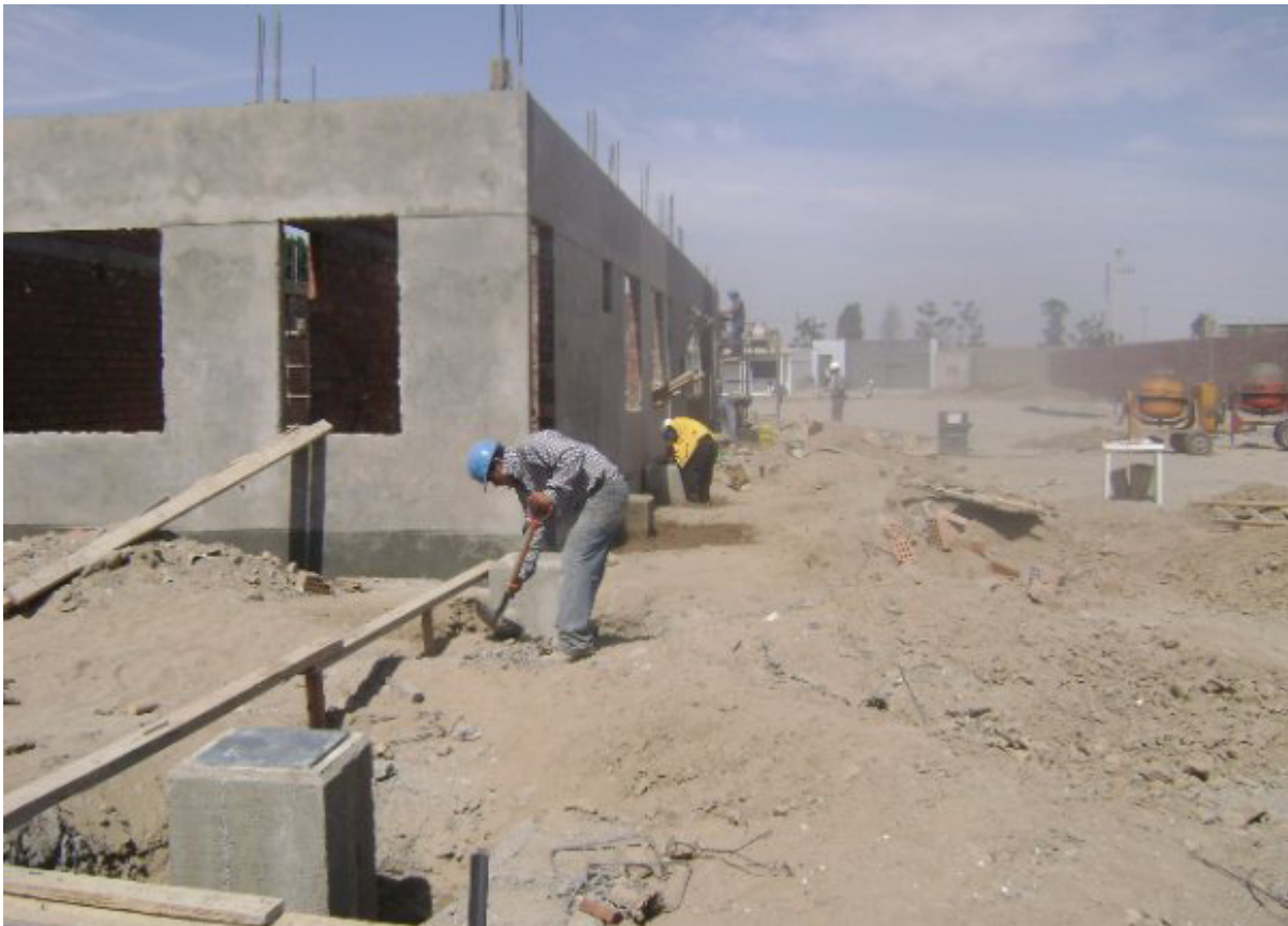
Byggnationen av SysTech's första bilprovingsanläggning i Ica, Peru, pågår för fullt och planeras öppnas under juni månad
