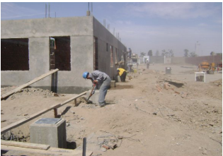
Byggnationen pågår av SysTech's första bilprovsningsanläggning i Ica, Peru
